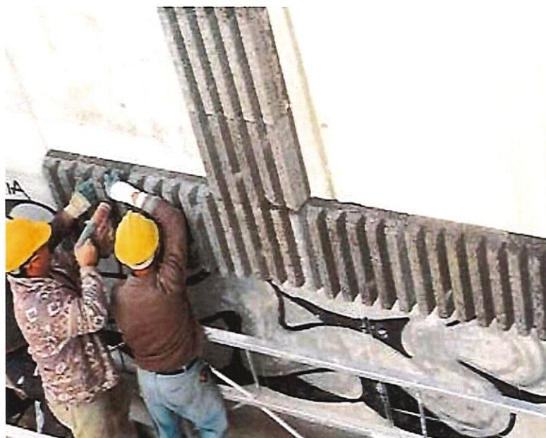
**Placas de concreto BBS aplicadas diretamente sobre muro**
