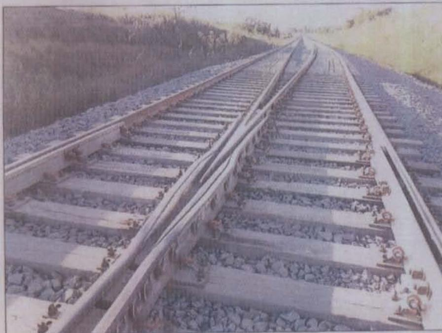
Foto 12 – AMV completo no pátio de cruzamento adjacente à PI inacabada sob BR-070.
