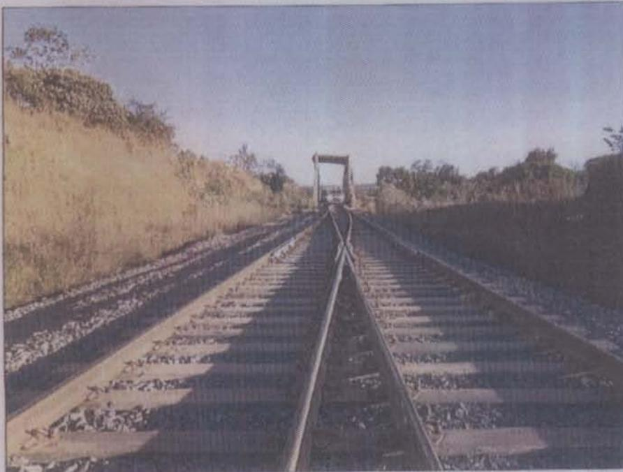
Foto 11 – AMV instalado no pátio de cruzamento adjacente à PI inacabada sob BR-070.
