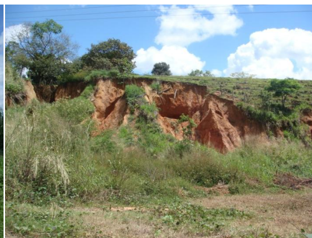
FIGURA 116 - Voçoroca ao lado da BR 222.
