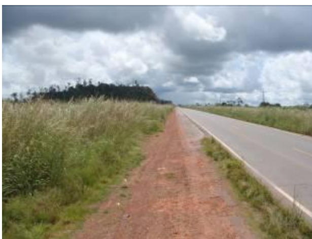
FIGURA 32 - Cruzamento do traçado da FNS com a rodovia BR-010 (Belém - Brasília).
