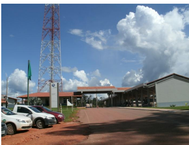
FIGURA 89 - Entrada da Empresa Hydro.
