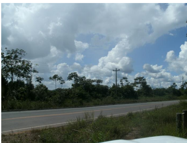
FIGURA 83 - Cruzamento da rodovia PA-256 como traçado da ferrovia.
