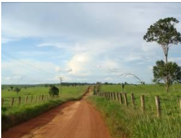
FIGURA 36 - Cruzamento do traçado da FNS com a rodovia BR – 222.
