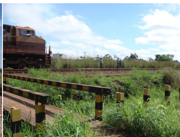
FIGURA 108 - Início do traçado da Ferrovia, cruzamento com a Ferrovia Carajás.
