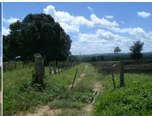
FIGURA 120 - Cruzamento da estrada rural com o traçado da Ferrovia.
