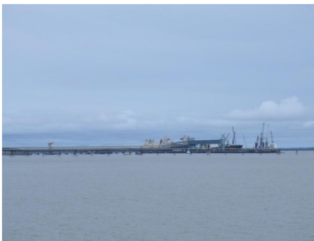
FIGURA 45 - Município de Barcarena-PA, Vila Nova Itupanema – Vista ao norte para o atual Porto do Conde.
