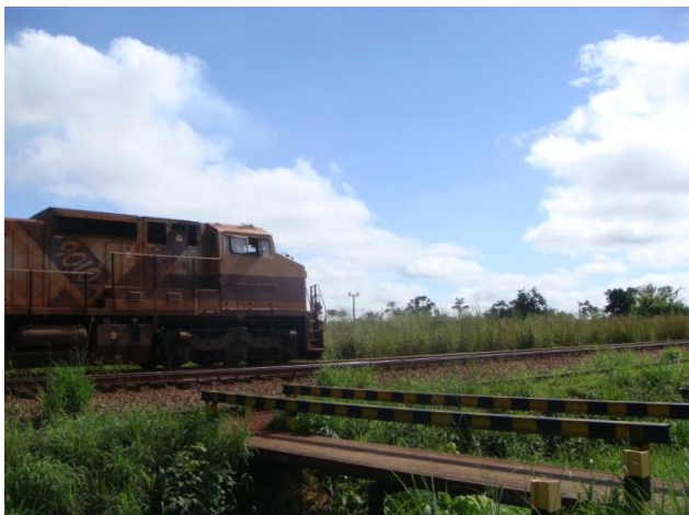
FIGURA 187 - Início do traçado da FNS, cruzamento com a Ferrovia Carajás.
