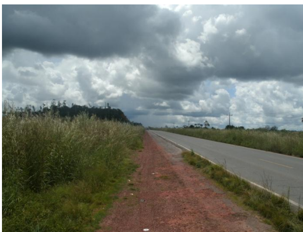
FIGURA 99 - Cruzamento do traçado da Ferrovia com a rodovia BR-010 Belém – Brasília.
