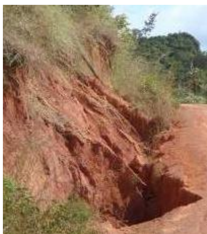
FIGURA 34 - Ponto na estrada para leste da Belém - Brasília, local de Voçorocas.
