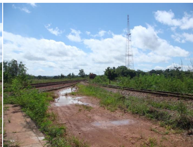
FIGURA 110 - Ferrovia Norte-Sul já existente, com a Ferrovia Carajás ao lado.
