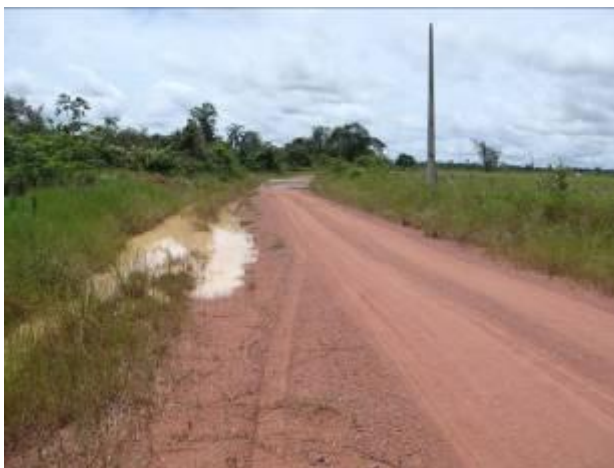
FIGURA 18 - Cruzamento do traçado da FNS com ramal do Km 35.
