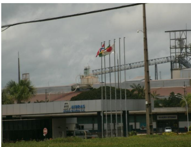
FIGURA 47 - Terminal Portuário do Município de Barcarena-PA.
