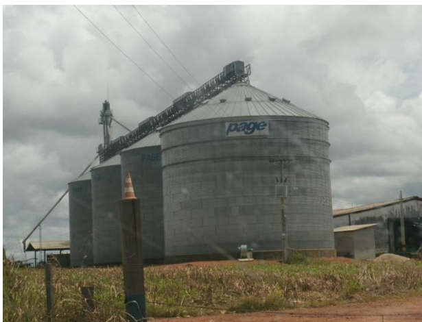
FIGURA 97 - 330. Fazenda, Cruzamento da estrada Bradesco com o traçado da Ferrovia.
