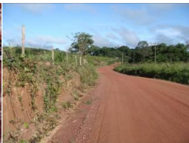
FIGURA 23 - Ponto ao longo da rodovia PA -140
