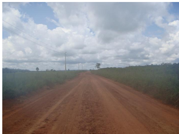
FIGURA 180 - Cruzamento do traçado da FNS com a estrada Bradesco.
