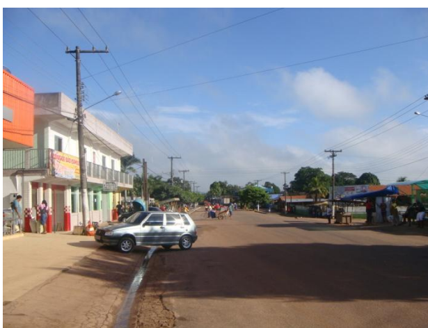
FIGURA 113 - Vila de Piquiá de Cima, área urbana. Provável cruzamento do traçado da Ferrovia com a rodovia BR-222.
