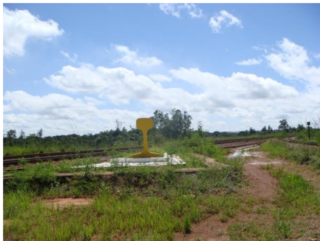
FIGURA 188 - Marco da FNS já existente, com a Ferrovia Carajás ao lado.
