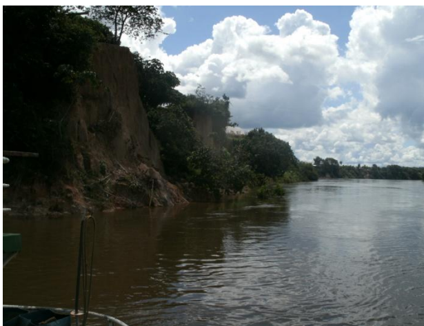
FIGURA 81 - Vista da balsa da Rodovia PA-256. Cruzamento da Ferrovia com o Rio Capim.
