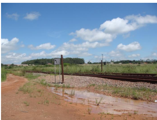
FIGURA 107 - Início do traçado da Ferrovia, cruzamento com a Ferrovia Carajás.
