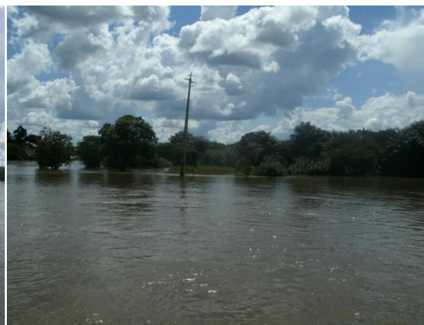
FIGURA 82 - Vista da balsa da Rodovia PA-256. Cruzamento da Ferrovia com o Rio Capim.
