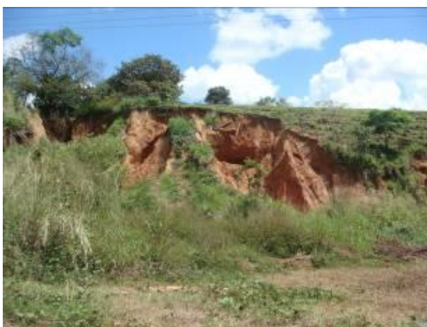
FIGURA 38 - Voçoroca ao lado rodovia BR-222.
