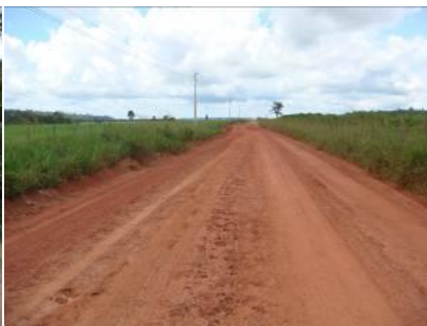
FIGURA 31 - Estrada que dá acesso aos silos, cruzamento com o traçado da FNS mais adiante.
