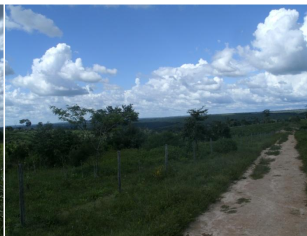
FIGURA 122 - Cruzamento do traçado da Ferrovia com a estrada de uma fazenda.
