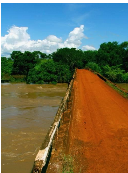
Figura 7– Ponte sobre o rio Meia-ponte com destaque para suas margens elevadas ao fundo. Fonte: Panoramio – Por: Fernando N Branco
