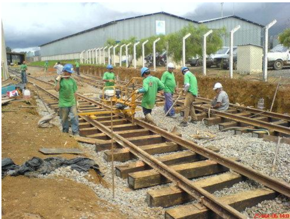
Figura 13: Obras na ferrovia existente no Porto Seco de Anápolis
