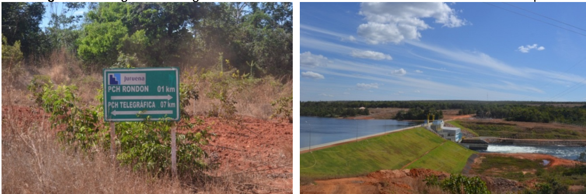
Figura 17: Registros fotográficos da PCH Rondon feitos durante a visita ao campo.
