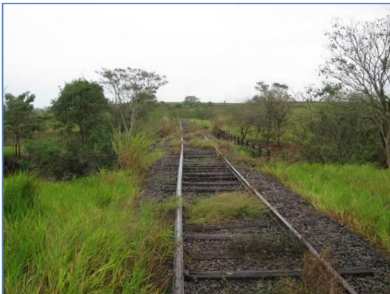
Foto 50: Linha férrea desativada próxima ao trevo de acesso para Ouro Verde. 22k – 435131 / 7625758
