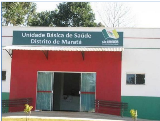
Foto 112: Unidade Básica de Saúde Distrito de Maratá, município de São Domingos/SC. 22J - 336996 / 7058706
