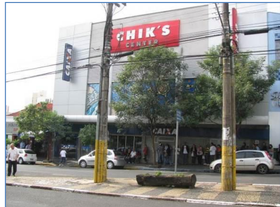
Foto 39: Agência da Caixa Econômica Federal. 22K – 459996 / 7553624
