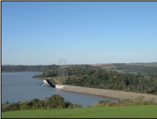
Foto 33: Reservatório da PCH Ludesa. APP's em bom estado de conservação 22 J 350451.50E / 7059470.33S
