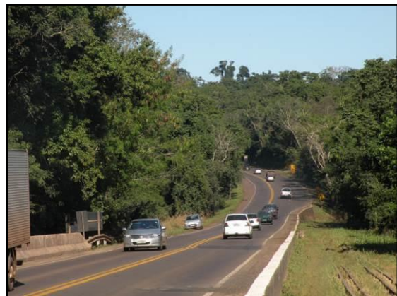
Foto 18: Travessia do rio Ivaí na PR 323. Fragmentos em bom estado de conservação 22 K 366896.01 E / 7392137.38 S
