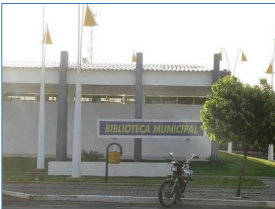
Foto 80: Equipamento Comunitário de Educação – Biblioteca Municipal Goioerê/PR. 22 J – 294799 / 7323470
