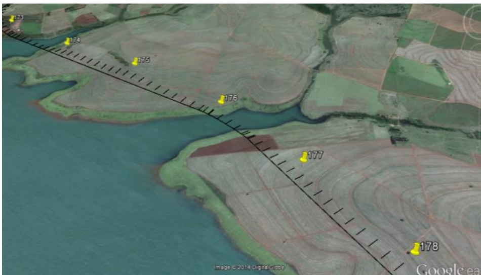
Área de APP sem cobertura vegetal – 22 K 405965,04 E 7504062,94 S
