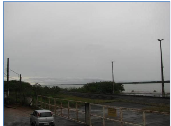
Foto 47: Estação de transbordo em Panorama (hidrovia x ferrovia) desativada. 22K – 412607 / 7639478
