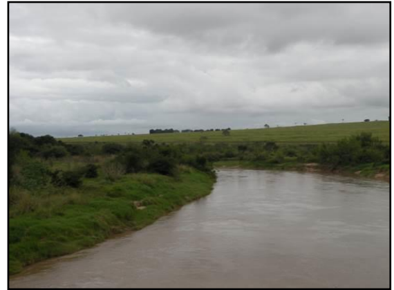
Foto 2: Áreas de Proteção Permanente em péssimo estado de conservação as margens da rodovia SP 501. 22 K 460735.53E / 7596026.11S
