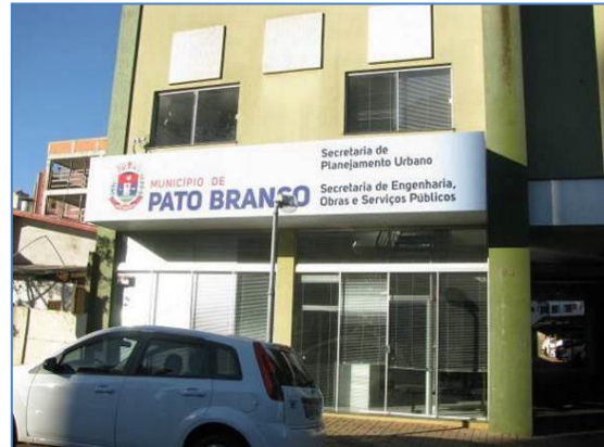
Foto 99: Secretaria Municipal de Planejamento e Obras de Pato Branco/PR. 22J – 332940 / 7098035
