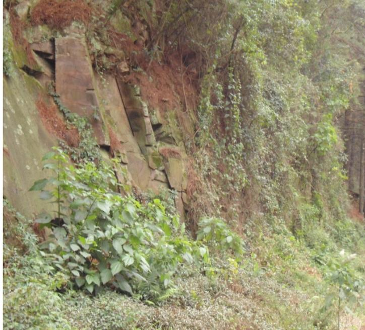
**Figura 16: Talude em rocha muito fraturada, sujeito a queda de blocos na BR-158**
