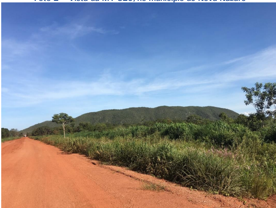
Foto 2 – Vista da MT-326, no município de Nova Nazaré
