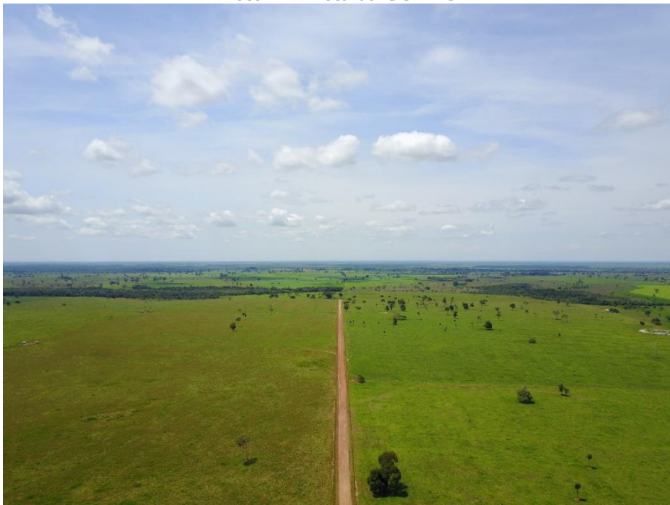
Foto 4 – Vista da GO-173
