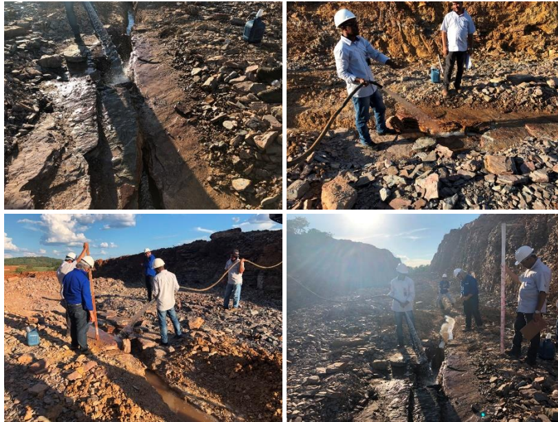
Figuras 05 a 08 – Preenchimento da fenda com água
