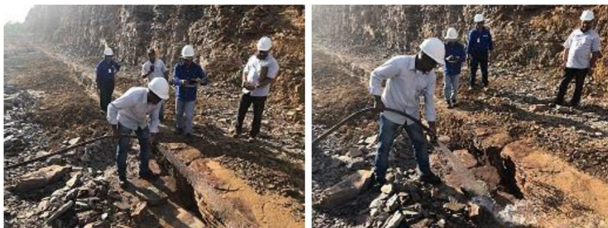
Figura 8. Limpeza da fenda (descontinuidade) - corte CA 039.
