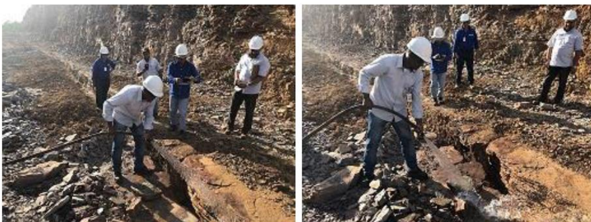
Figura 8, a seguir, mostra a limpeza feita na fenda para realização do ensaio.
