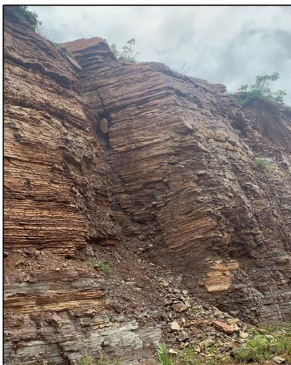
Figura 7. Sistemas de descontinuidades em maciço rochoso (corte CA 039).
