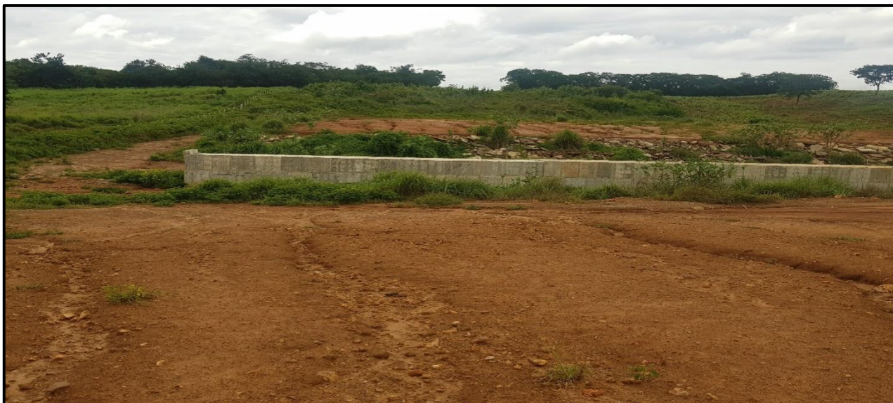
Figura 12 - OAC parcialmente executada km 677+800.
