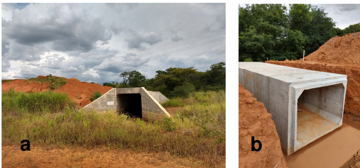
Figura 10. Dispositivos de drenagem executados (a) ou em execução (b) verificados durante a visita técnica.
