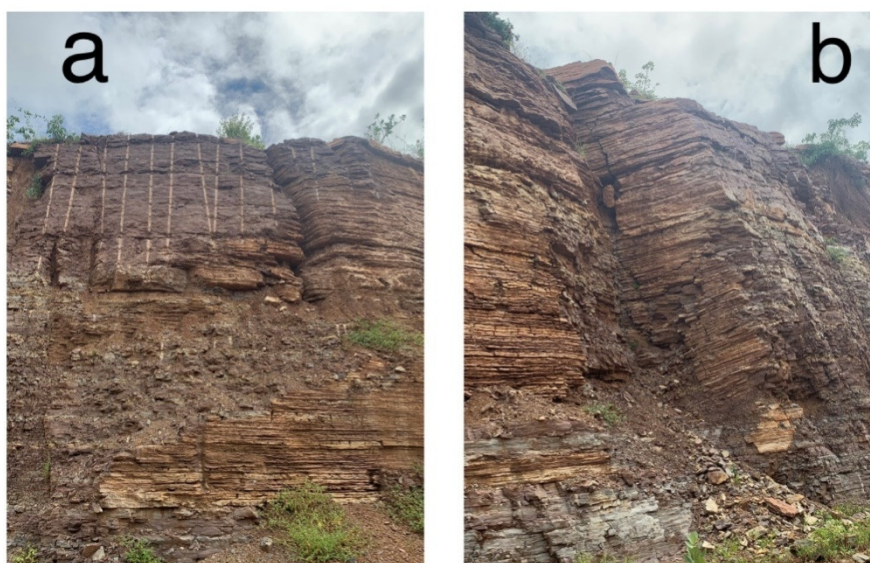
Figura 9. Maciço rochoso heterogêneo, muito fraturado e alterado no corte C 039.
