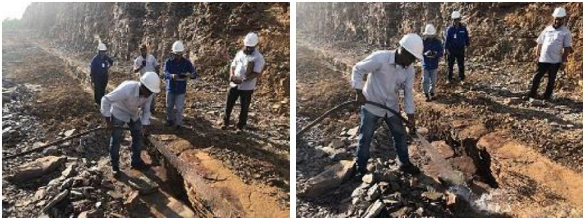
Figura 8. Limpeza da fenda (descontinuidade) - corte CA 039.
