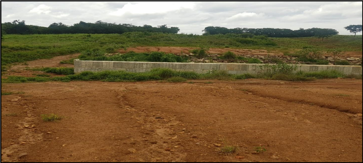
Figura 12 - OAC parcialmente executada km 677+800.
