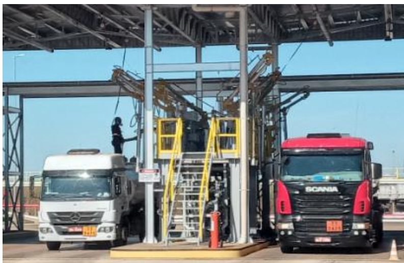
Figura 6: Ilha ou plataforma de carregamento do tipo top loading
