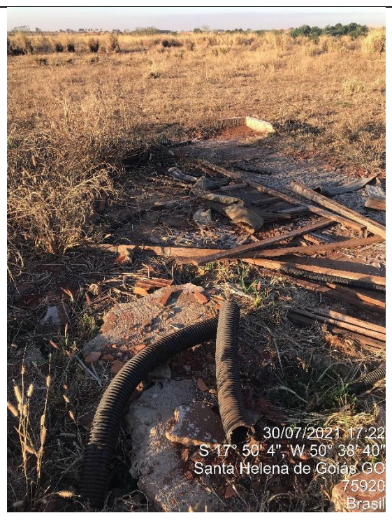
Figura 16. Resíduos de construção civil após a demolição dos abrigos temporários do local. Fonte: Autor
