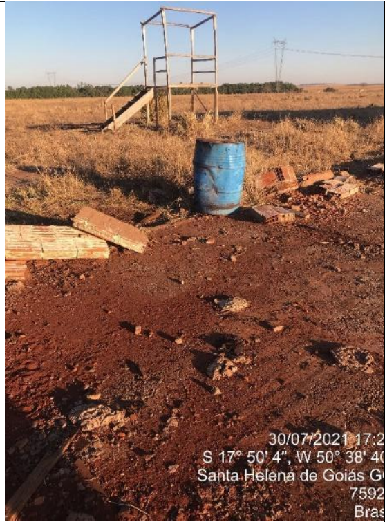
Figura 10. Visão geral da área onde foi instalada o transbordo da obra. Fonte: Autor
