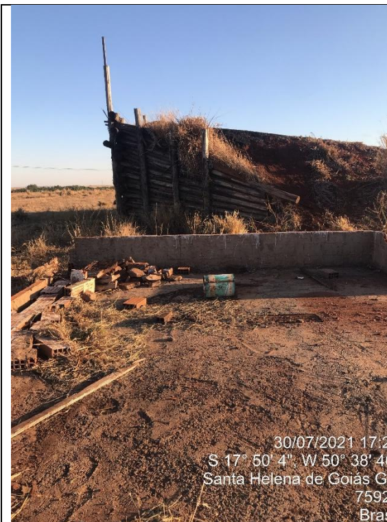
Figura 17. Rampa improvisada feita com solo e massa asfáltica. Fonte: Autor
