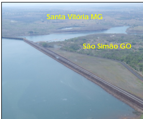
Barragem da Usina Hidrelétrica de São Simão no Rio Paranaíba, fronteira entre os Estados de Goiás e Minas Gerais.
