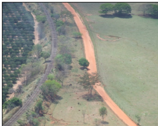
Local onde será construído o entroncamento ferroviário da FNS com a ALL, município de Estrela d'Oeste (SP).
