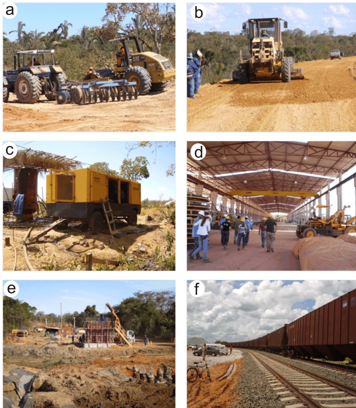
a, b – terraplanagem; c - grupo gerador; d - fábrica de dormentes; e - obras de artes especiais; f - Superestrutura
