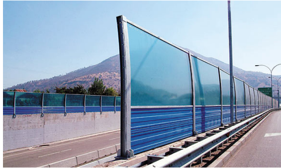
FIGURA 1.7.6 - BARREIRA ACÚSTICA DE ACRÍLICO- LINHA VERMELHA, RJ.
