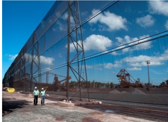
FIGURA 1.6.4 - BARREIRA DE PROTEÇÃO DE VENTO. PÁTIO FERROVIÁRIO EM VERMONT, EUA
