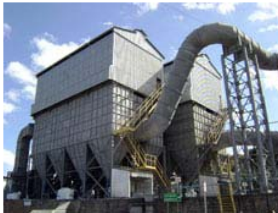
FIGURA 1.6.2 - FILTRO BIN VENT INSTALADO NO TOPO DE SILOS GRANELEIROS (FORNECEDOR: TERSEL)
