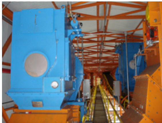
FIGURA 1.6.2 - FILTRO BIN VENT INSTALADO NO TOPO DE SILOS GRANELEIROS (FORNECEDOR: TERSEL)
