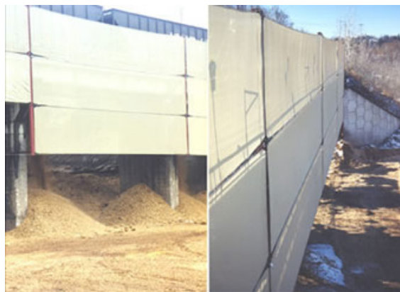
FIGURA 1.6.5 - BARREIRA DE PROTEÇÃO DE VENTO. (SAMARCO - ES).
