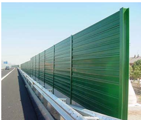
FIGURA 1.7.3 - PAINÉIS METÁLICOS - LISBOA, PORTUGAL.
