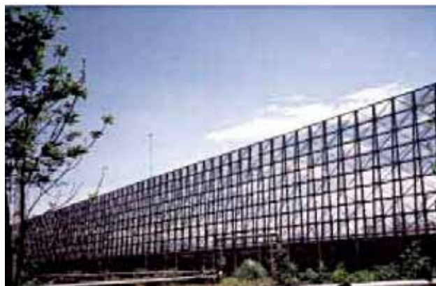
FIGURA 1.6.5 - BARREIRA DE PROTEÇÃO DE VENTO. (SAMARCO - ES).
