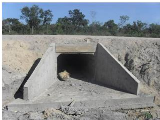
FNS - km 615+620 – BSCC 2,0x1,5m (Corredor ECO - Córrego Sucuri)
