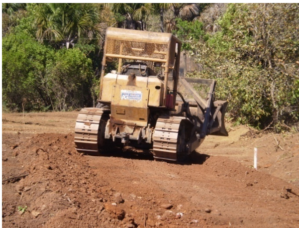
Figura 3.4.1. Utilização do trator de esteira (D6) para supressão da vegetação em empreendimentos ferroviários (Fonte: OIKOS)
