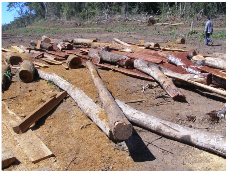
Figura 3.4.3. Separação dos troncos de grande porte (DAP>25 cm) para posterior empilhamento ou utilização nas obras de arte da ferrovia.
