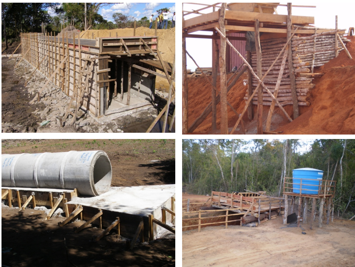
Figura 3.4.4 – Destinação do material lenhoso em obras de arte, central de concreto instalações de apoio
