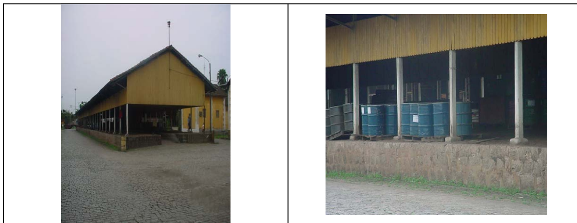
FIGURA 2.2.4 - GALPÃO PARA ARMAZENAMENTO E TAMBORES DE ACONDICIONAMENTO
