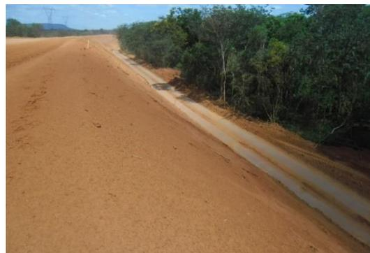
Figura 29: Ocorrência de erosão resolvida com a conformação do terreno
