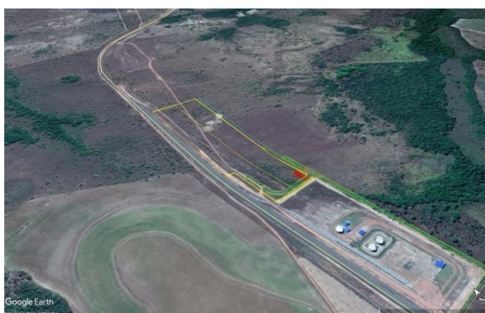
Figura 7 – Terminal de Minérios de Guaraí – Pátio de Guaraí/TO
