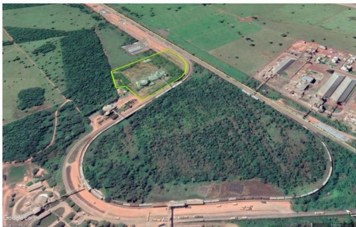
Figura 6 – Terminal Lote 05 do Pátio Intermodal de Porto Franco/MA
