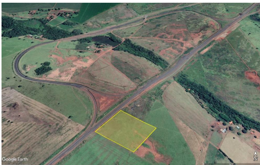
Figura 9 – Terminal de Granéis Líquidos (TSG02) – Pátio de Santa Helena de Goiás/GO
