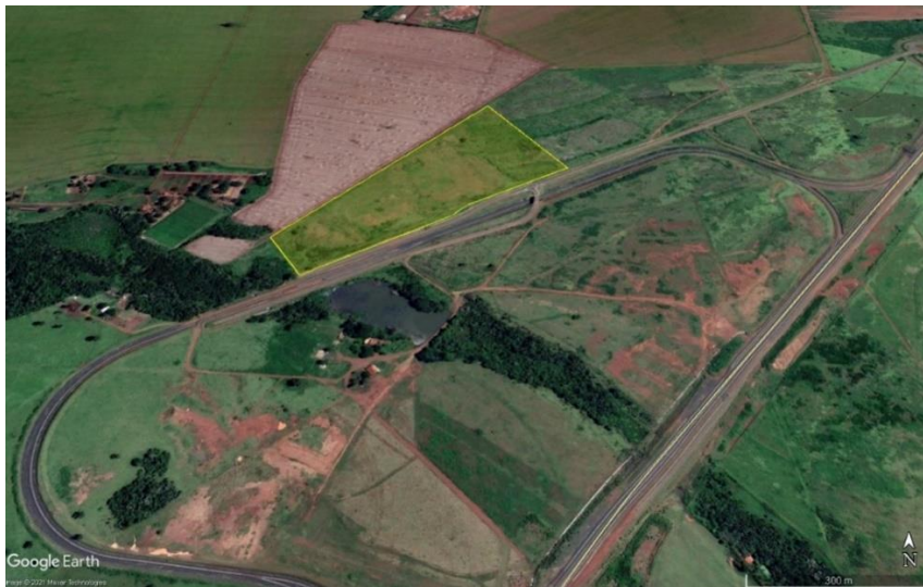
Figura 10 – Terminal de Carga Geral Containerizada – Pátio de Santa Helena de Goiás/GO
