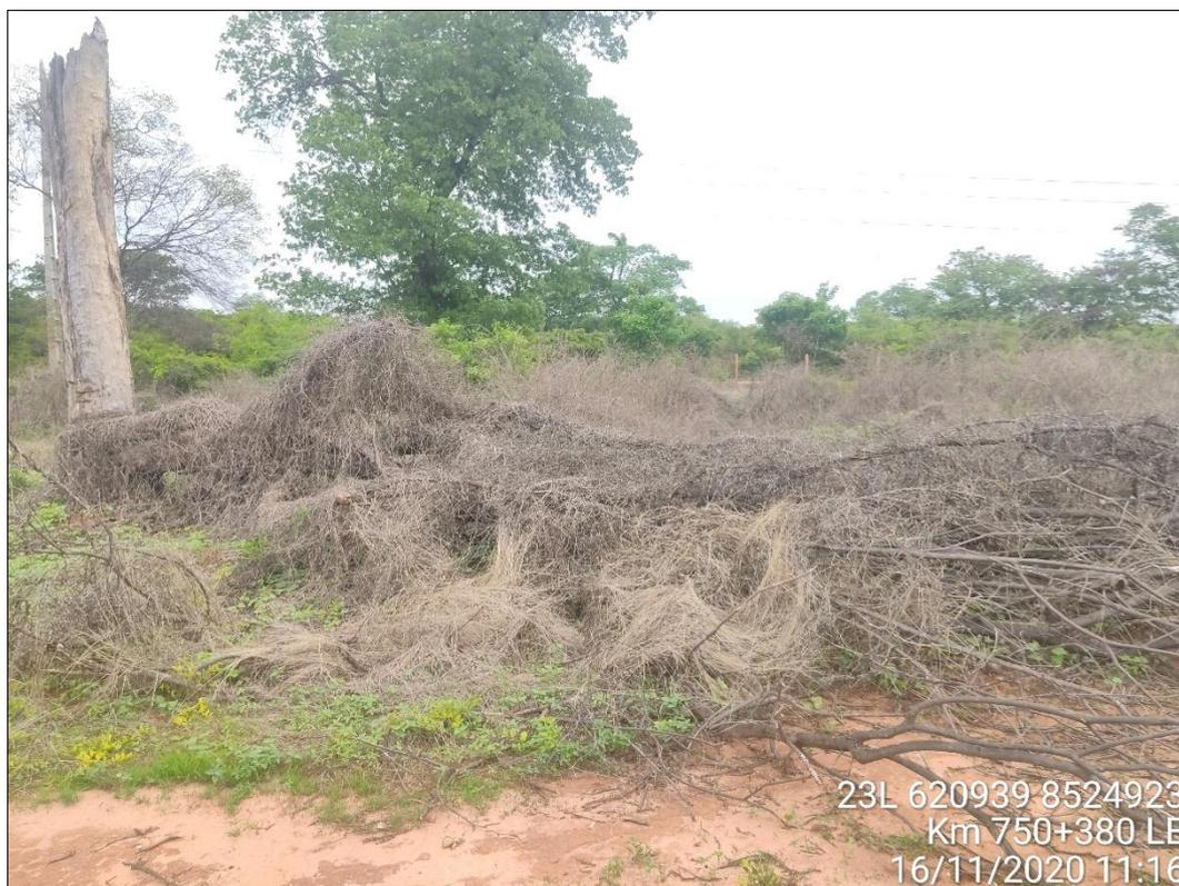
Foto 087 - Expurgo sem conformação adequada
