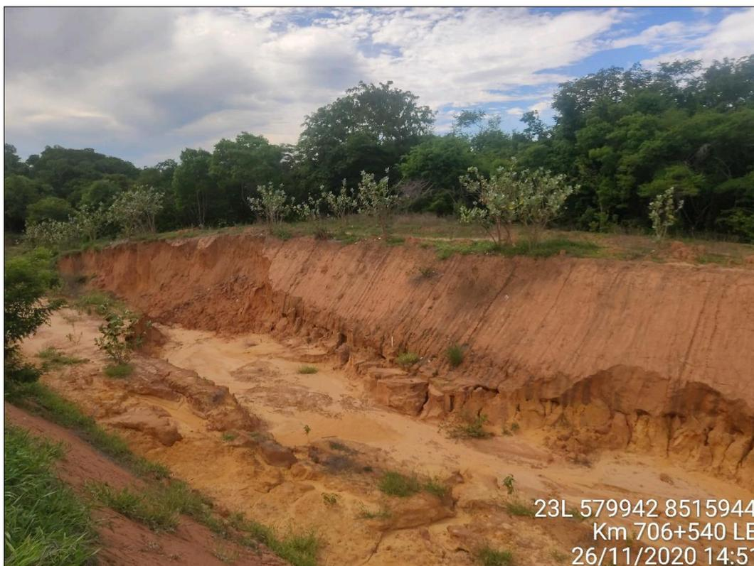
Foto 090 – Passivo ambiental ocasionado por falta de conclusão e manutenção da obra.
