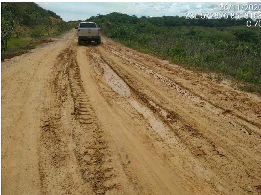
Foto 85 - Sublastro deteriorado – km 698+870
