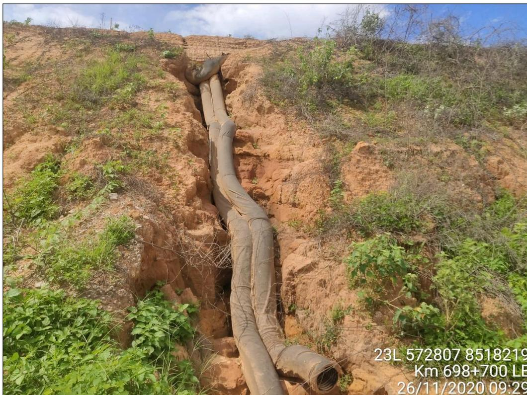
Foto 091 – Imagem dos processos erosivos existe na obra.
