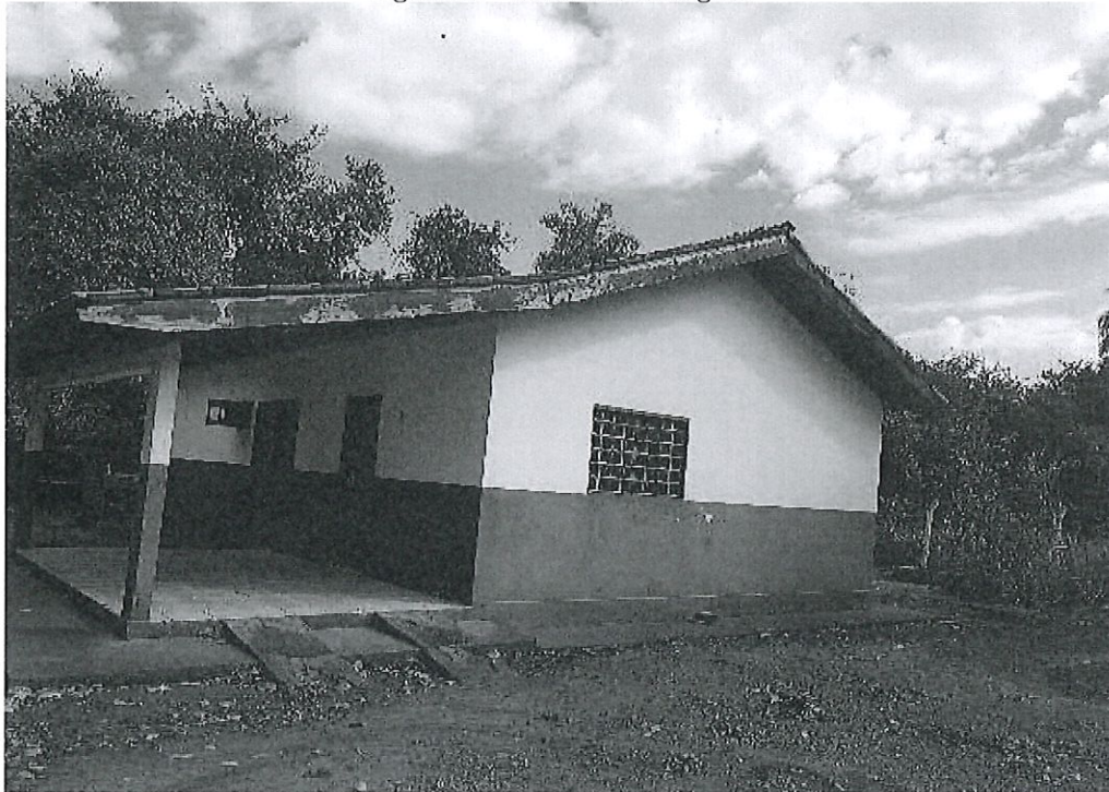
Figura 39 – Casa do encarregado
