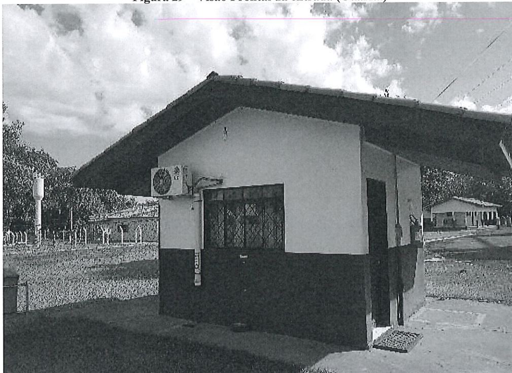
Figura 29 – Visão Frontal da entrada (Guarita)
