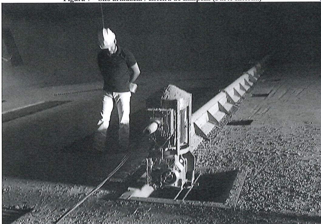
Figura 7 – Silo armazém / Esteira de Limpeza (Parte Interna)
