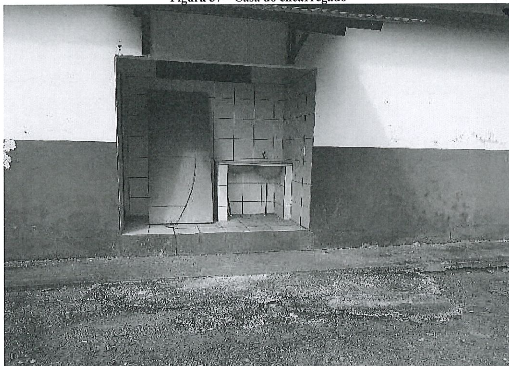
Figura 37 – Casa do encarregado
