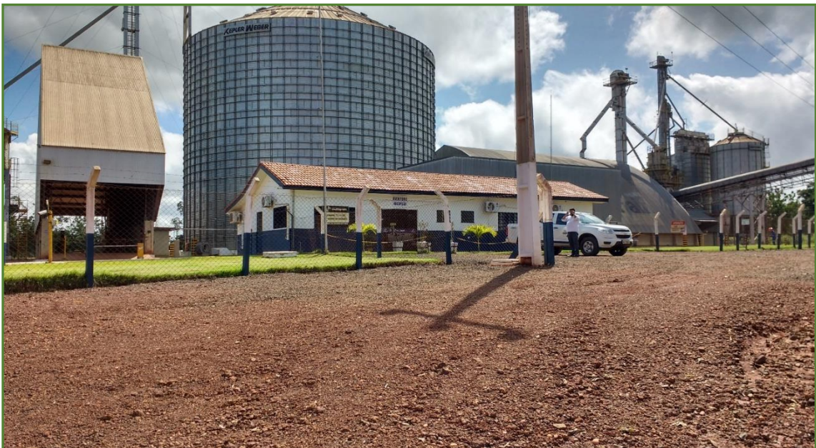
Imagem 07 – Vista frontal do Terminal Intermodal do Lote 05
