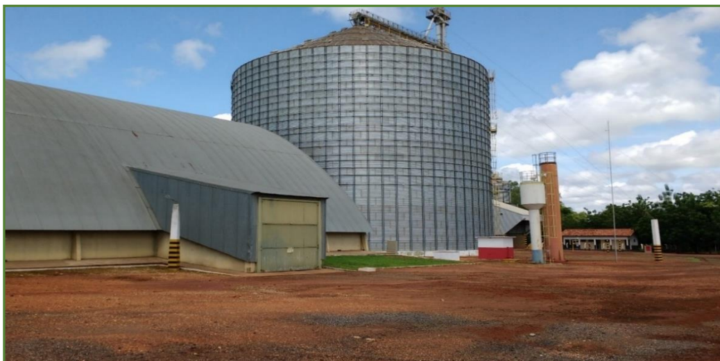
Imagem 05 – Armazém Graneleiro e Silo Metálico do Terminal Fonte: Arquivo Valec
