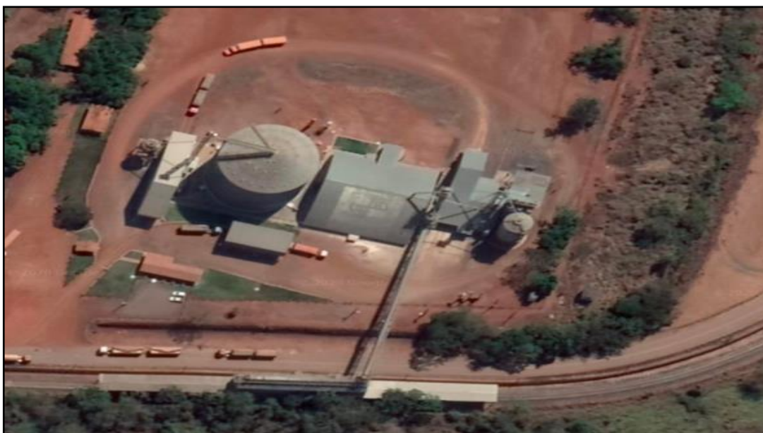
Imagem 06 – Vista aérea aproximada do Terminal Fonte: Google Maps
