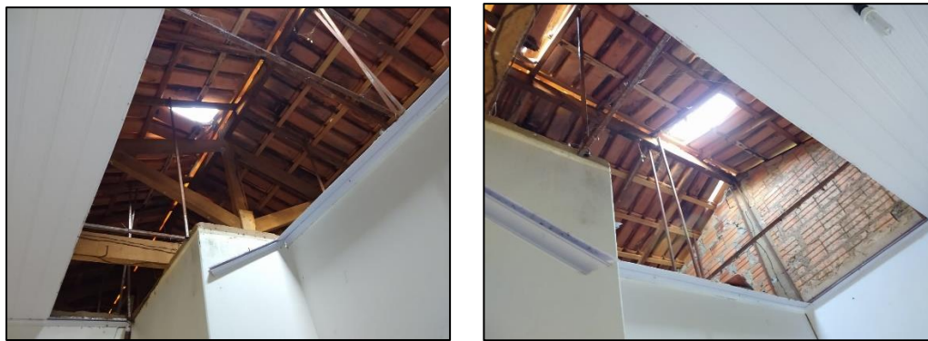
Imagem 04 – Telhado em um dos quartos do alojamento
