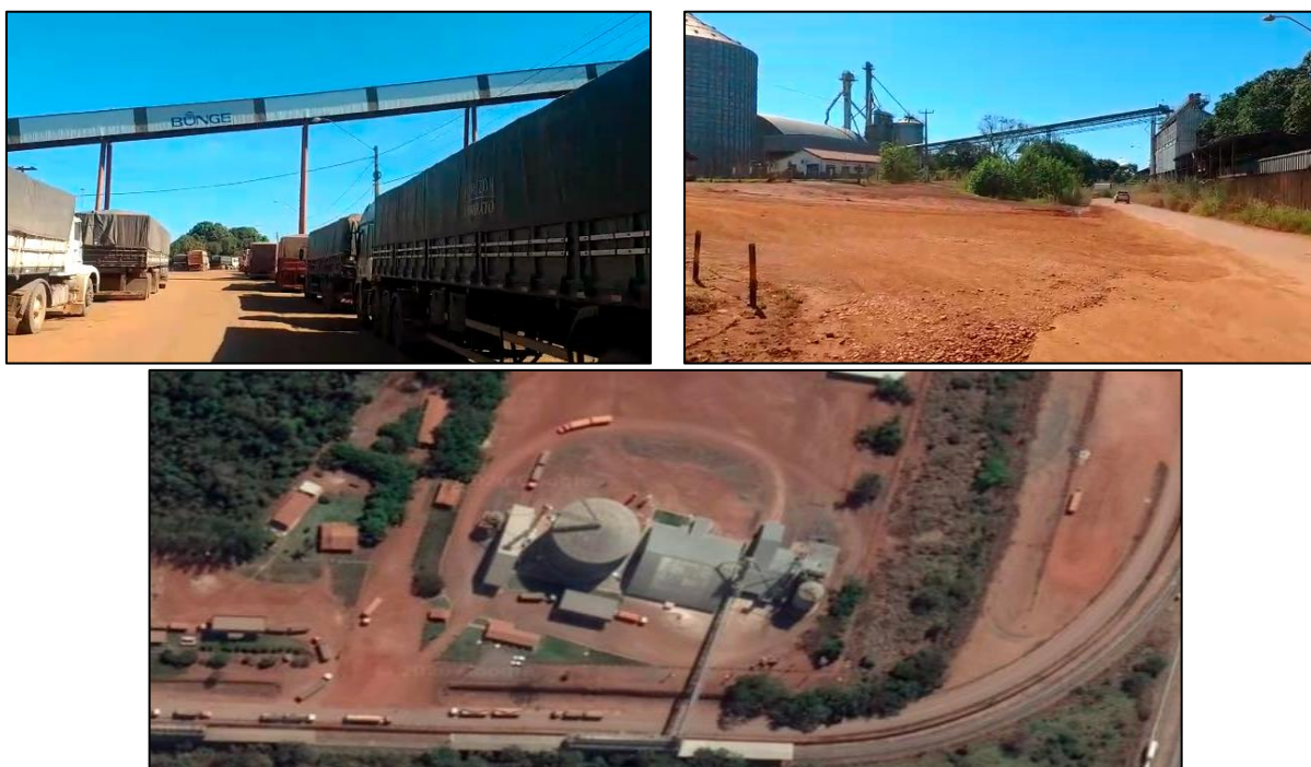
Imagem 13 – Vias de acesso comprometidas e fileira de veículos em frente ao lote 05
