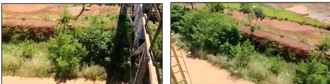
Imagem 09 – Valetas de drenagem
