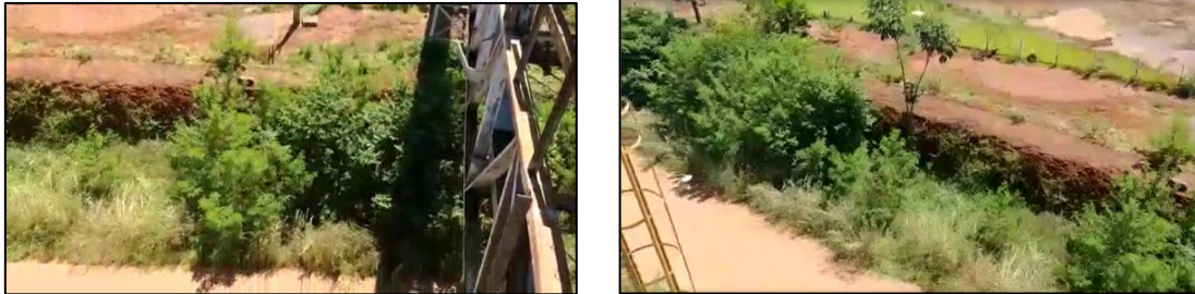
Imagem 11 – Exposição dos taludes
