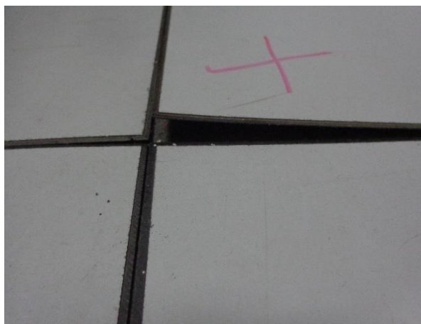
Figura 31: Vértice da lajota saliente.
