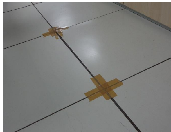
Figura 32: Lajota nivelada com fita adesiva - vista 1.
