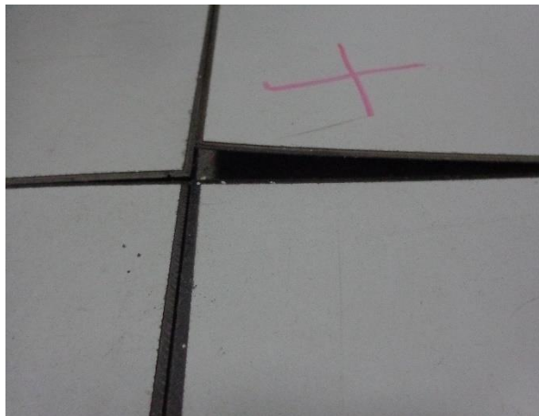
Figura 32: Vértice da lajota saliente.
